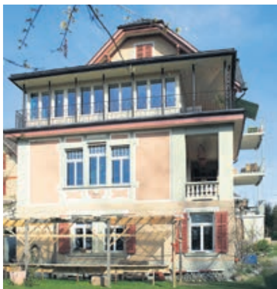
Bei der ehemaligen Pension am Kapuzinerweg 25 wurde schützenswerte Bausubstanz geschickt mit neuen Bauteilen kombiniert.
