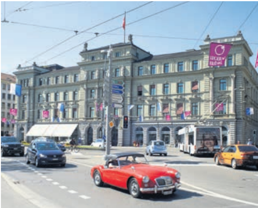
Der eindrucksvollste Neorenaissancebau des Kantons Luzern: das 1886 bis 1888 erbaute ehemalige Verwaltungsgebäude der Gotthardbahngesellschaft.
