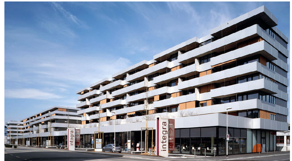
Verdichtete Bauen mit Mischnutzungen entlang viel befahrener Strassenräume, «Integra» in Wallisellen.
