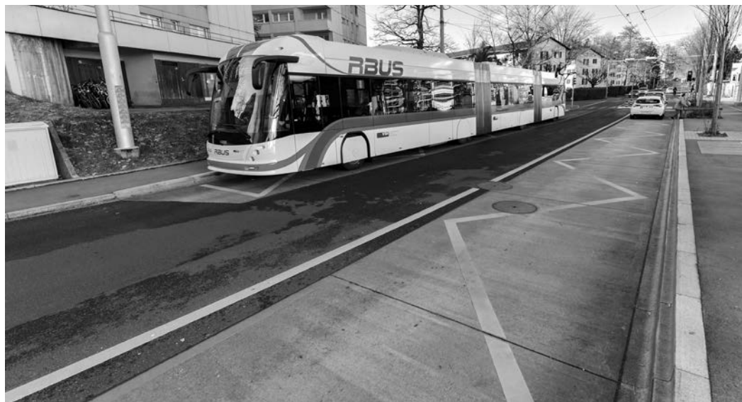
Die Bushaltestelle Schönbühl wurde 2016 im Rahmen eines Sanierungsprojekts hindernisfrei ausgestaltet.
