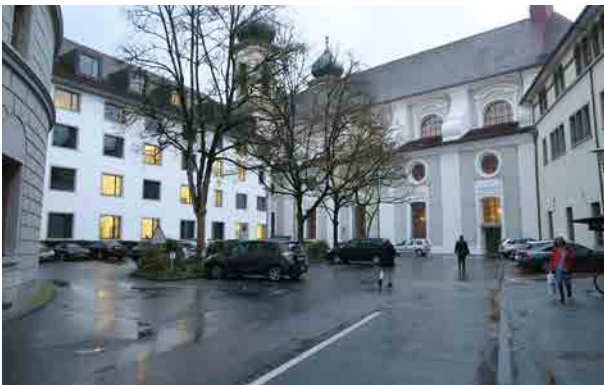
Östlicher Hof des Regierungsgebäudes mit Parkplatz
