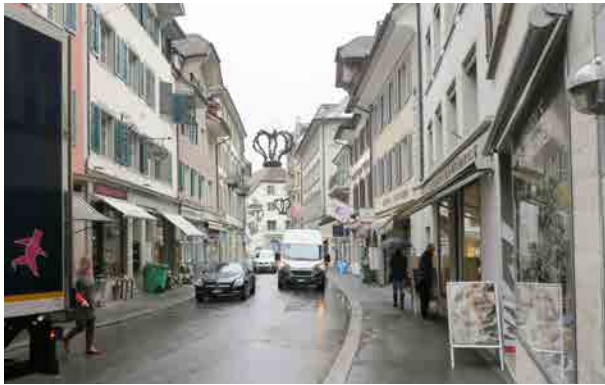
Pfistergasse mit Fahrbahn, Trottoirs und Anlieferverkehr
