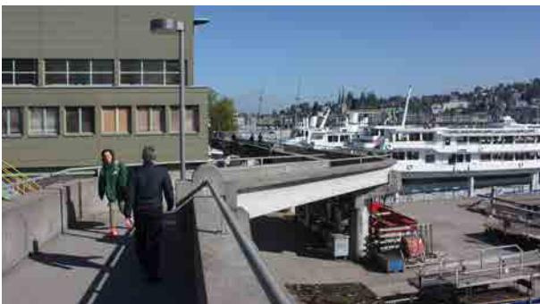
Hafenanlage mit Fussgängersteg
