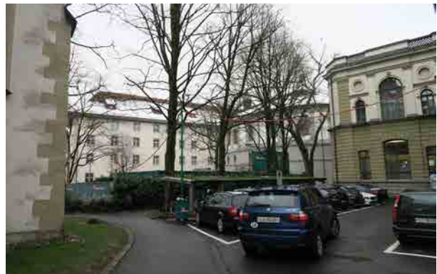
Westlicher Hof des Regierungsgebäudes
