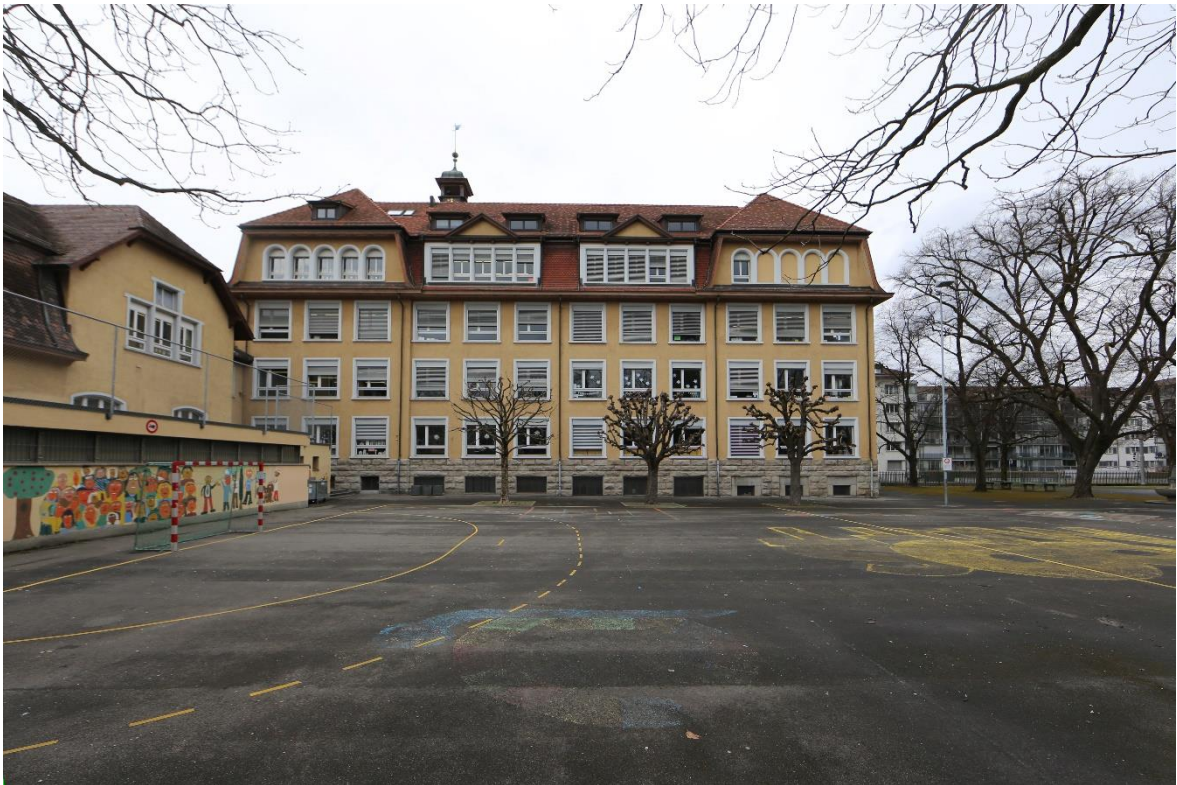
Abb. 6: Südfassade mit seitlichem Garderobenanbau (1969)
