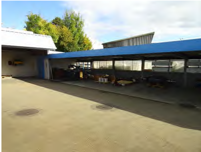
Abb. 27 östlicher Unterstand Jost AG (planteam 21.10.2016)
