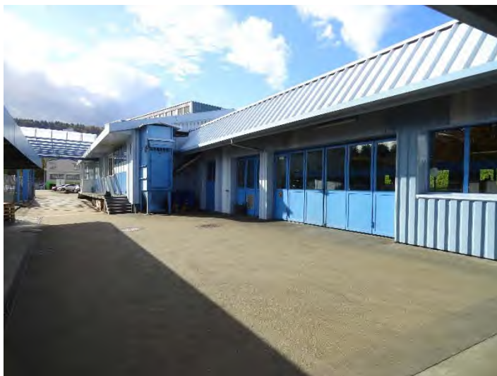
Abb. 29 Filteranlage, Kompressorraum und Werkstatt 3 Jost AG (planteam 21.10.2016)
