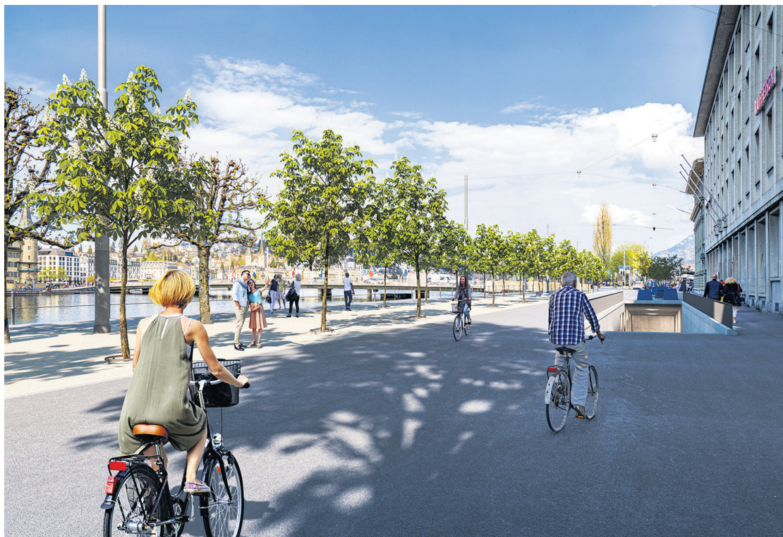
Eine zweite Baumreihe, ein klimafreundlicher Mergelbelag unter den Bäumen, eine separate Fahrbahn für Velofahrende und eine unterirdische Velostation prägen die neue Bahnhofstrasse.
