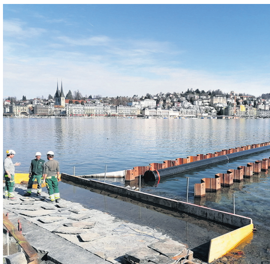
Für die See-Energie-Zentrale Inseliquai wurde eine neue Wasserfassung in den See gelegt.
