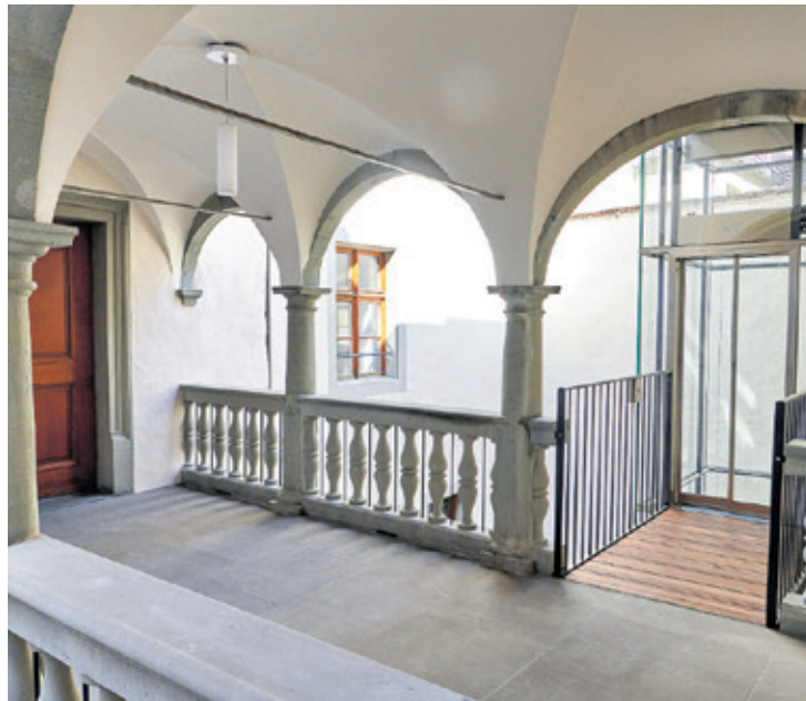
Der Innenhof – die Verbindungsstege wurden von 1616 bis 1618 gebaut – ist neu mit einem Lift erschlossen.
