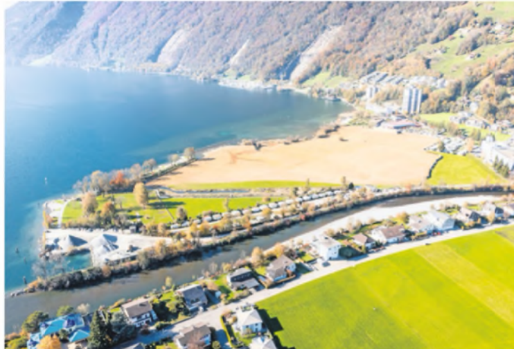
Das Muotadelta soll in der Hopfräben in Brunnen revitalisiert werden, verlangt das Bundesgericht. Ein neuer Campingplatz würde das erschweren.
