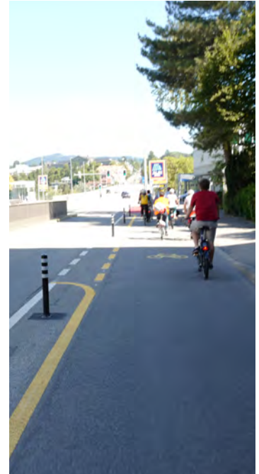
Geschützter Radstreifen (Protected-Bike-Lane).
