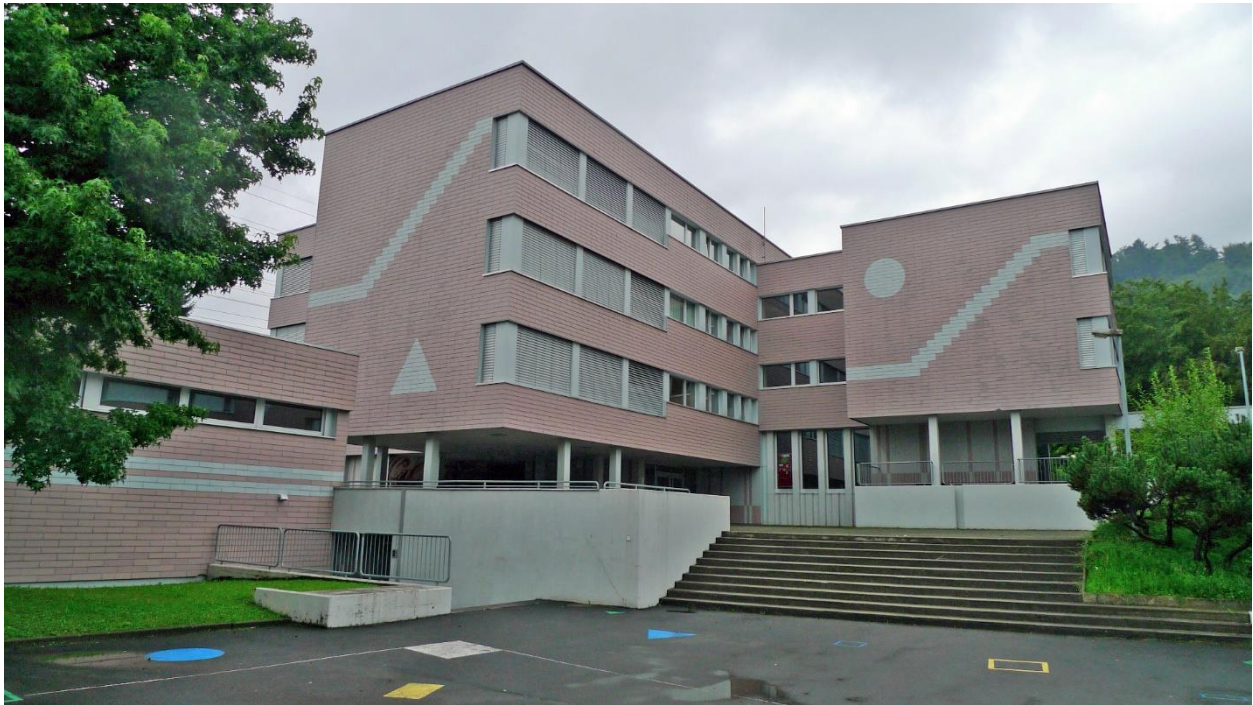
Abb. 2: Ansicht Nord Bestandsgebäude, Schulgebäude mit Klassenräumen
