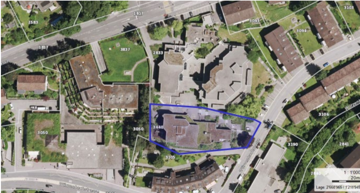
Abbildung 1: Lage des ehemaligen Schulhauses Schädtrüti im Quartier, blau markiert.
