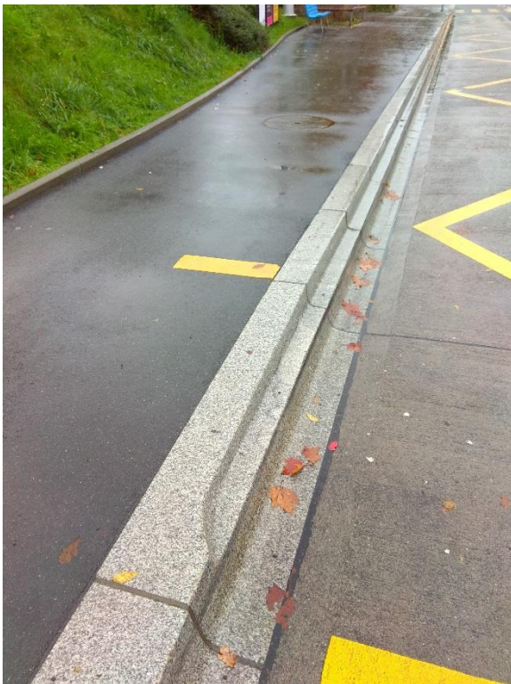
Abb. 2: Zürich-Bord an Pilothaltestelle Langensandstrasse Schönbühlcenter
