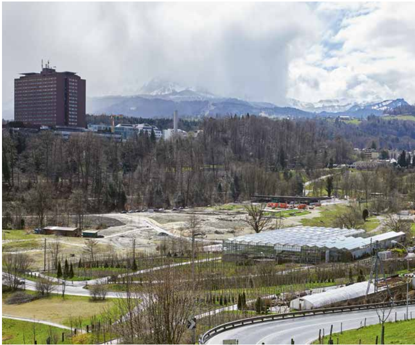
Neubau der Stadtgärtnerei im Ried.
