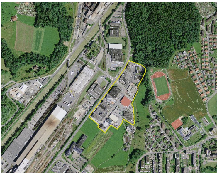
Abb. 3: Gebiet Staldenhof Nord
