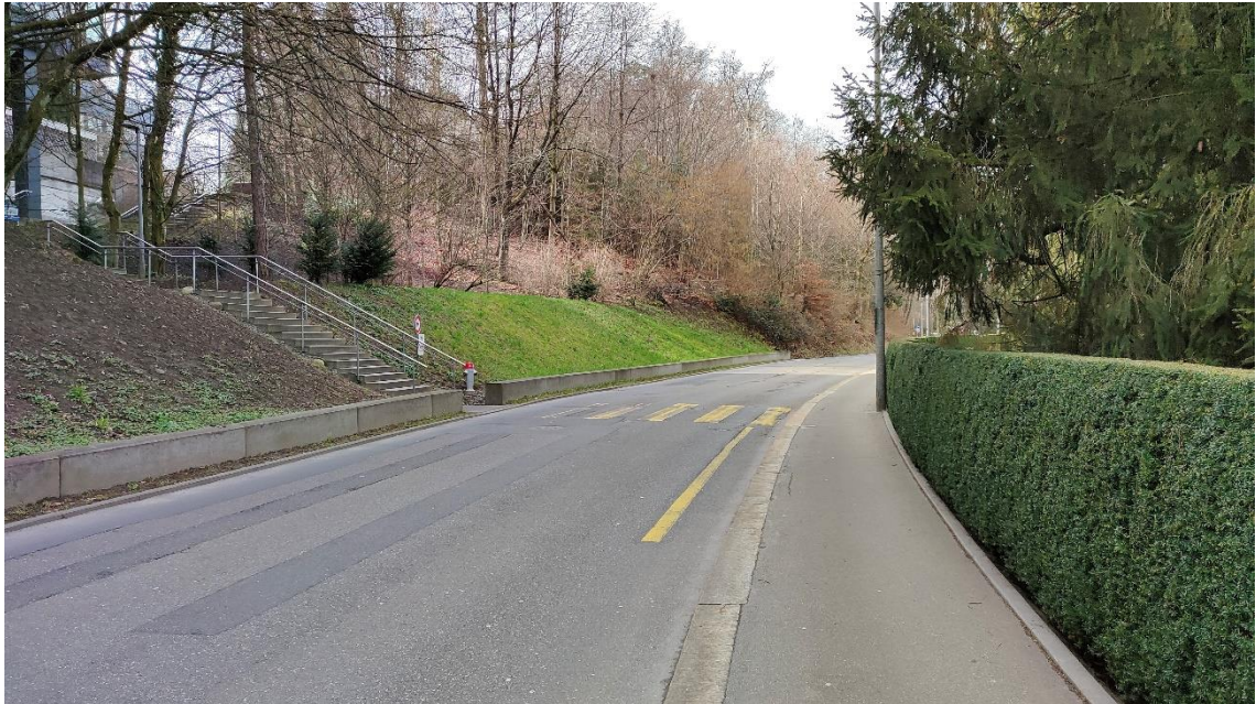
Abbildung 3 Fussgängerverbindung Kantonsspital – Friedhof, Mitte des Perimeters
