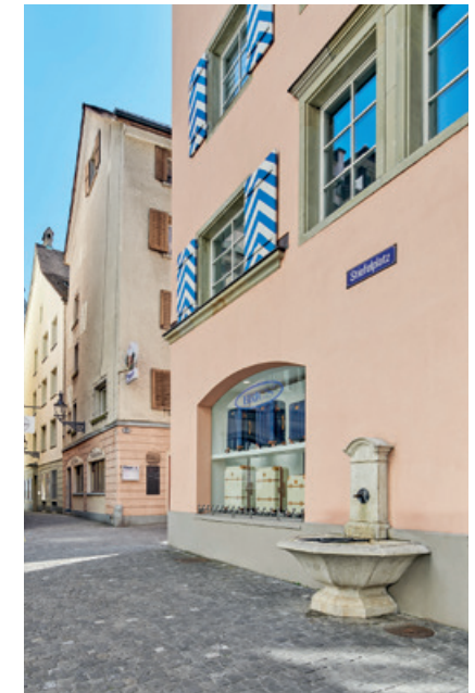
Der Wandbrunnen nach der Sanierung. Dieser ist ein typisches Beispiel einfacher klassischer Brunnen zur Zier der kleineren Plätze.
