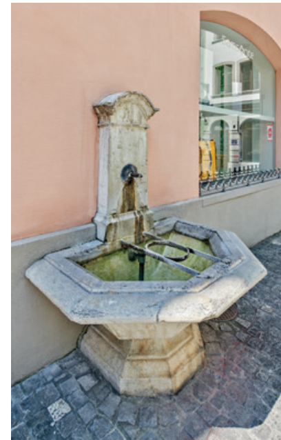
Der Brunnen vor der Reinigung und Sanierung. Das Wasser kommt aus dem alten Brunnennetz.
