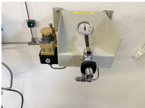
Atemschutz-Abfüllstation 200 bar
