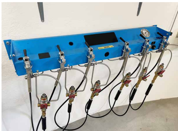
Atemschutz-Abfüllstation 300 bar
