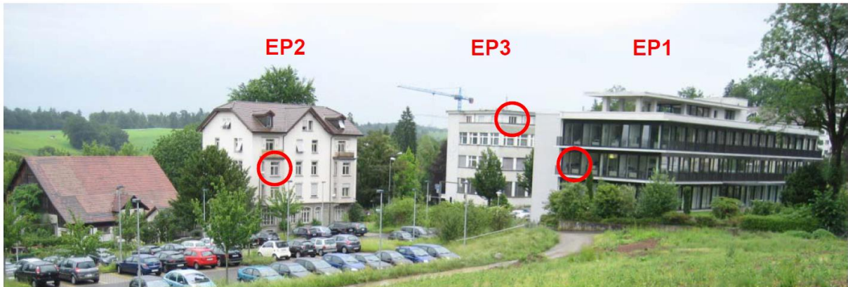
Abbildung 24: Empfangspunkte für die Betriebslärm-Berechnung beim Personal-Parkhaus, Luzerner Kantonsspital (aus dem UVB zum LU.42 Parkhaus Ost, LUKS TBS, Basler & Hofmann, 16. März 2017 [5])
