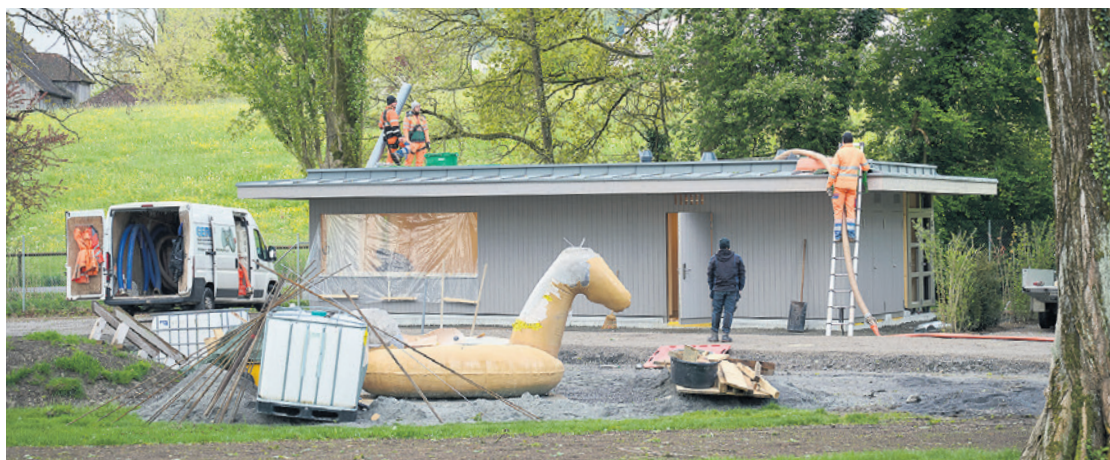
Auch das Gebäude mit Kiosk und Toiletten beim Strand und das Einhorn werden bis am 30. Mai fertig sein.
