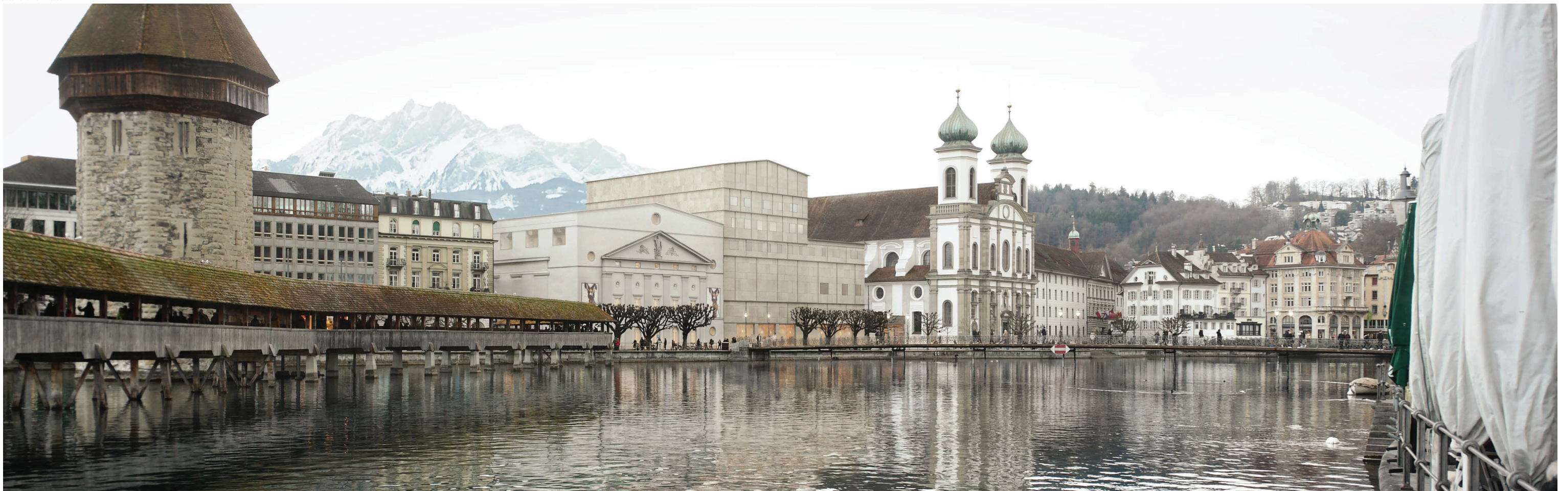
Der Baukörper des Theaters bildet einen Anker in diesem Ensemble, und schon aus städtebaulichen Gründen sollte das bestehende Volumen und das Erscheinungsbild seiner Architektur der Ausgangspunkt für die Erweiterung und Umgestaltung des Theaters sein.
