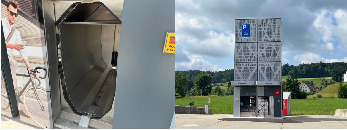
Abbildung 42: Vollautomatische, platzsparende Fahrradparktürme von V-Locker (Testanlage Stettbach Zürich, eigene Bilder)
