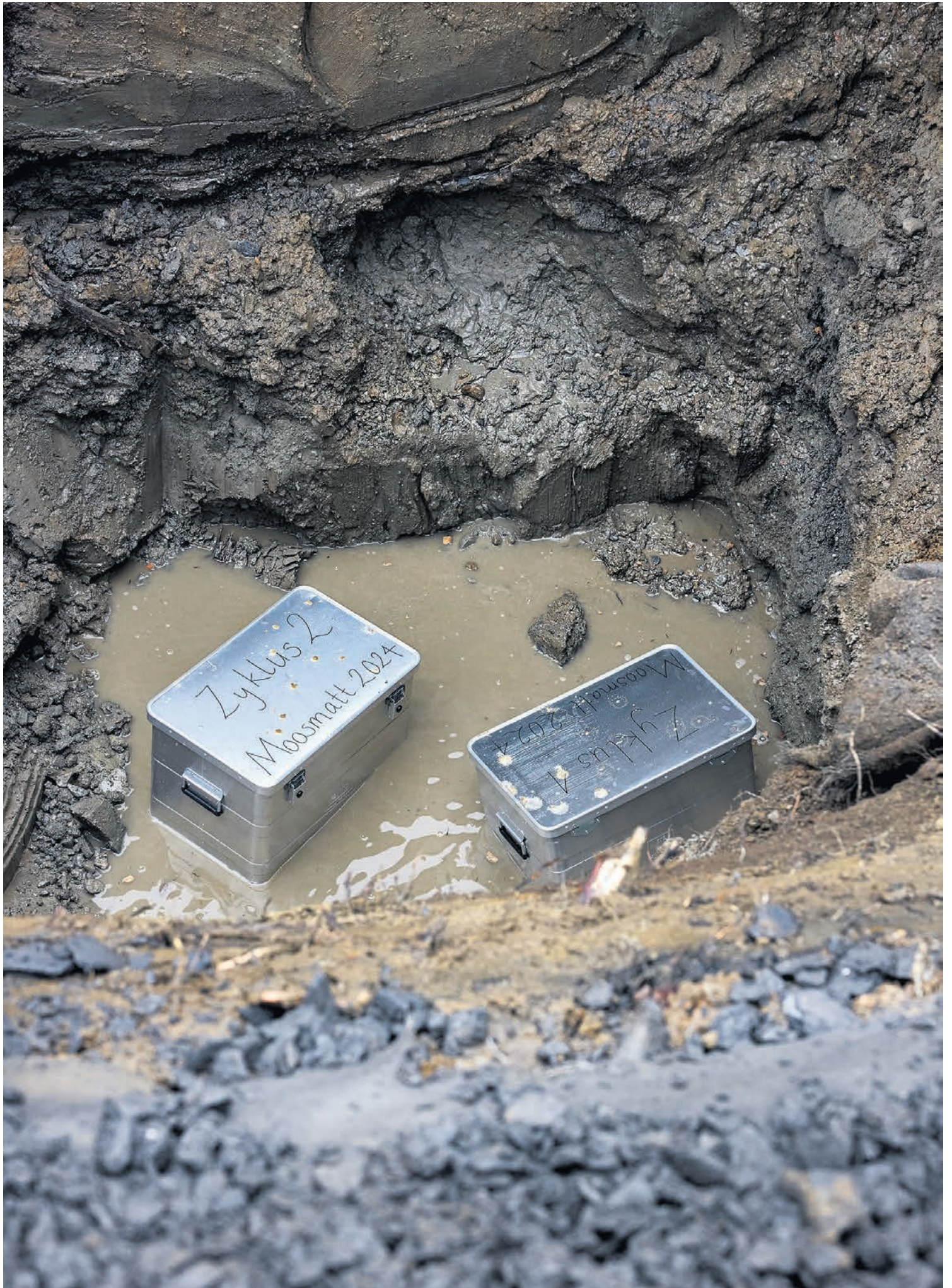
Eine jahrhundertealte Tradition wird auch beim Neubau des Schulhauses Moosmatt hochgehalten: Ein symbolischer Grundstein wird gelegt. Die Aluboxen enthalten Gedanken, Zeichnungen und Zukunftswünsche der Kinder.
