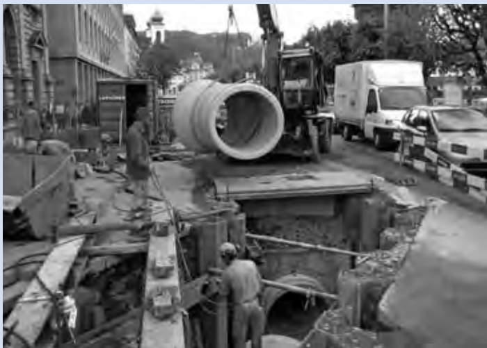
Sanierungsarbeiten an der Bahnhofstrasse im Oktober 2005
