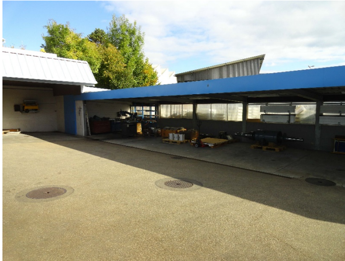
Abb. 27 östlicher Unterstand Jost AG (planteam 21.10.2016)
