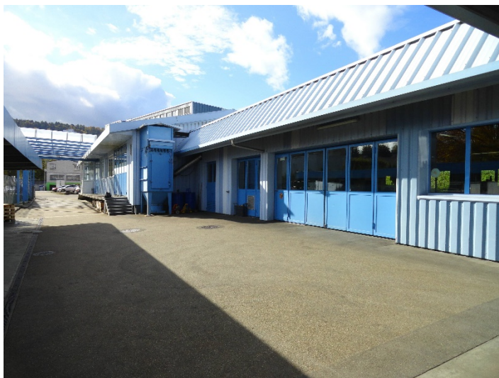
Abb. 29 Filteranlage, Kompressorraum und Werkstatt 3 Jost AG (planteam 21.10.2016)
