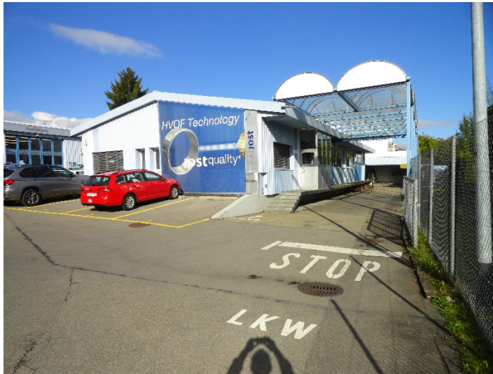
Abb. 30 Blick in Richtung Norden auf den Eingangsbereich der Jost AG (planteam 21.10.2016)
